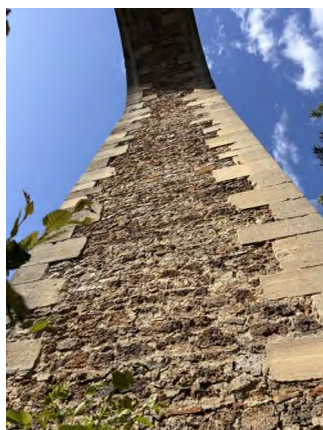
Grande Arche de l'aqueduc de Buc
